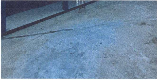
Fotografía 7. Red de agua potable, sustitución de tubería línea principal en todo el establecimiento.
