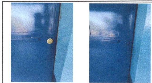
Fotografía 2. Sustitución de chapas de puertas de metal en Modulo 1 y 2.
