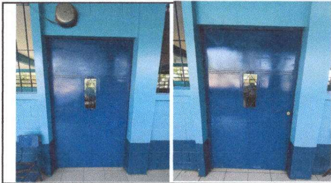
Fotografía 1. Mantenimiento a estructura de puertas de metal Modulo 1 y 2
