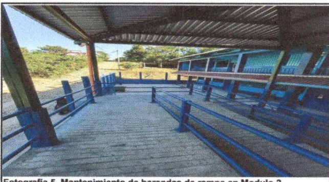
Fotografía 5. Mantenimiento de barandas de rampa en Modulo 2.
